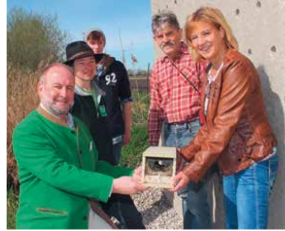
Bau eines Uferschwalbenhauses mit 120 Nisteinrichtungen.
