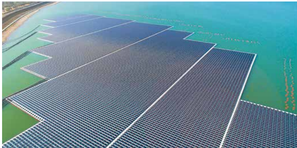
Auf dem See des Kieswerks Weeze/Hüdderath soll mit einer schwimmenden Photovoltaikanlage grüner Strom gewonnen werden.
