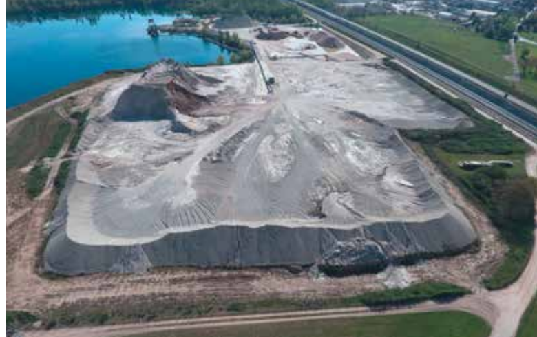
Lagerfläche für das Tunnelausbruchmaterial: Durch eine gezielte Aufbereitung konnten rund 700.000 m 3 Deponievolumen eingespart werden.
