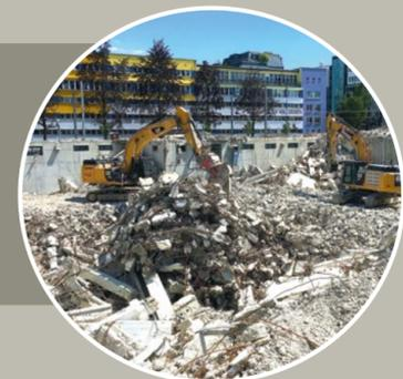
Bau- und Abbruchabfälle aus selektivem Rückbau von Gebäuden und technischen Bauwerken, Straßenaufbruch und Bodenaushub werden auf ihre Verwertbarkeit untersucht.
